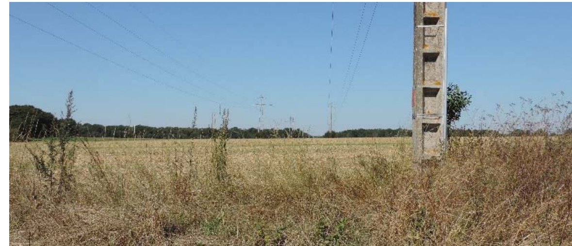
Photo 30 : Les deux lignes électriques traversant la zone du projet
