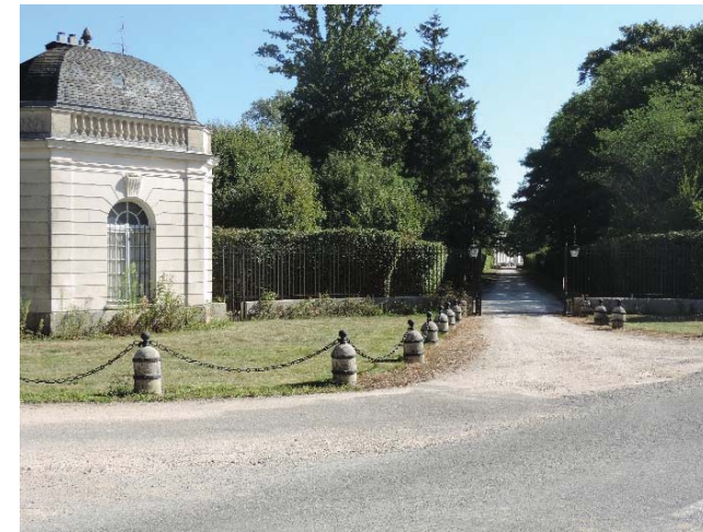
Photo 20 : Accès sud-ouest du château
