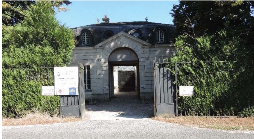
Photo 19 : Entrée sud du château
